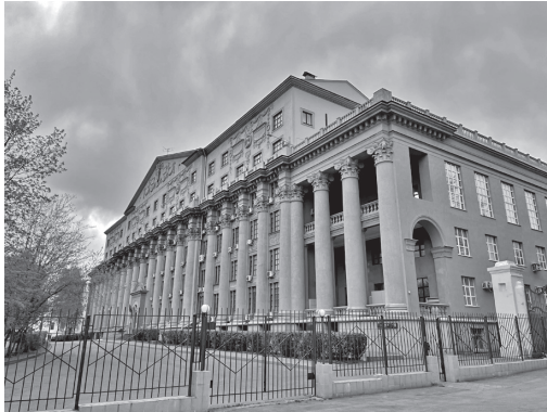
Рис. 9. Здание Института горного дела АН СССР (ныне ИМБ РАН) Арх. И.В. Жолтовский, Ю.Н. Шевердяев, К.И. Соломонов, Ш.А. Айрапетов, 1951–1960. Общий вид. Фото автора, 2022
